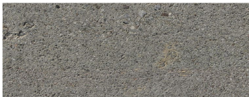
Placă de beton fără hidroizolație
