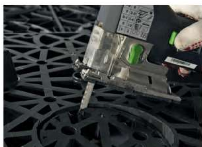
Decuparea unei deschideri pentru adaptorul pentru conectarea țevelor
