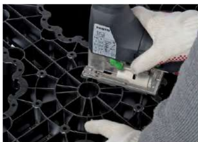
Decuparea unei deschideri pentru adaptorul pentru conectarea țevelor
