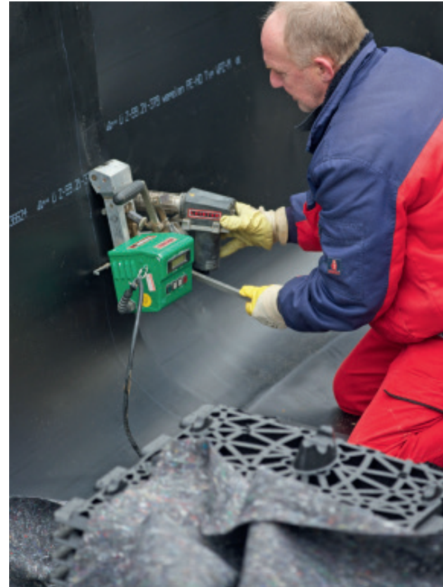
Membrana hidroizolatoare este apoi sudată.
