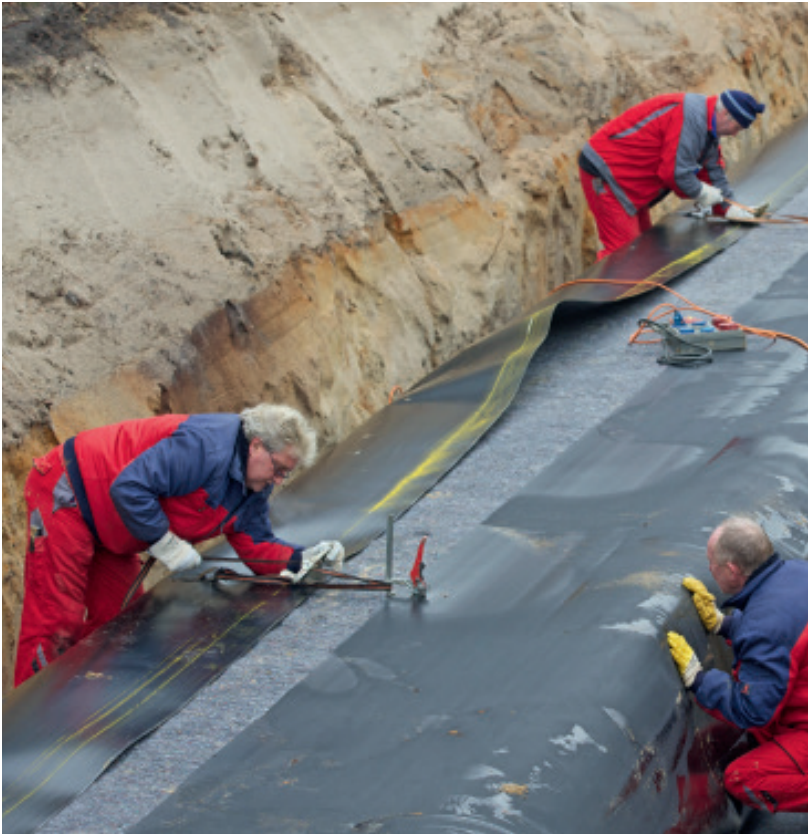
Sistemul de retenție este învelit într-o membrană de protecție interioară și apoi într-o membrană hidroizolatoare.
