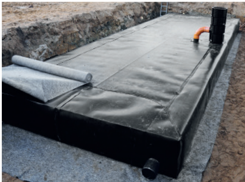
Membrana de protecție exterioară se aplică după ce a fost instalată membrana hidroizolatoare
